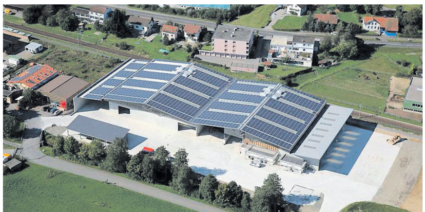
Eine imposante Anlage wurde für die Transport AG Aarau in Kölliken realisiert
