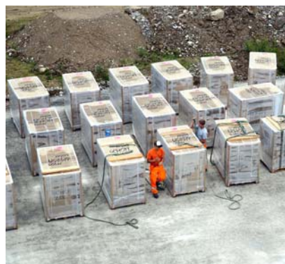
Paletten mit den PV-Modulen werden bereit gemacht für den Transport aufs Dach per Heli. (Fotos: Eco Energie A Plus AG)
