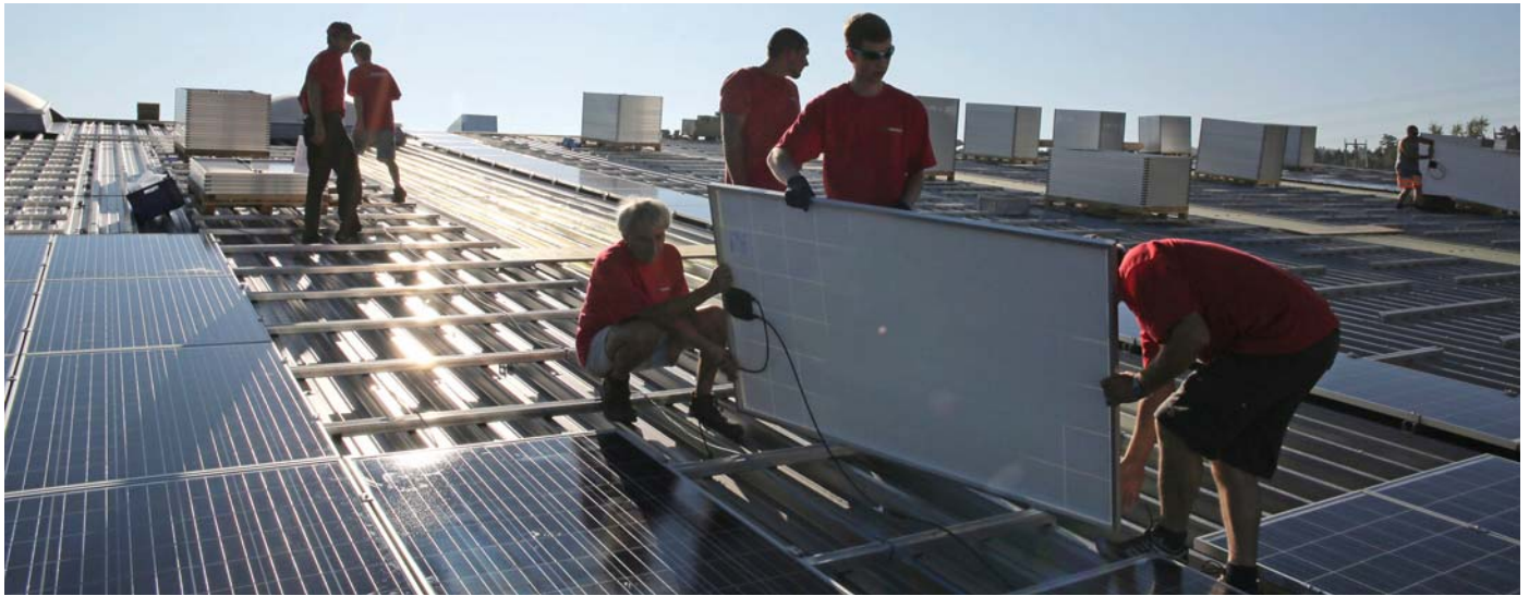
Montage der Module.
