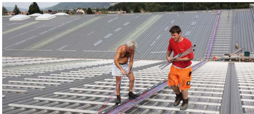
Das Montagesystem ist zur Aufnahme der PV-Module auf dem Trapezblech-Dach montiert. (Fotos: Eco Energie A Plus AG)
