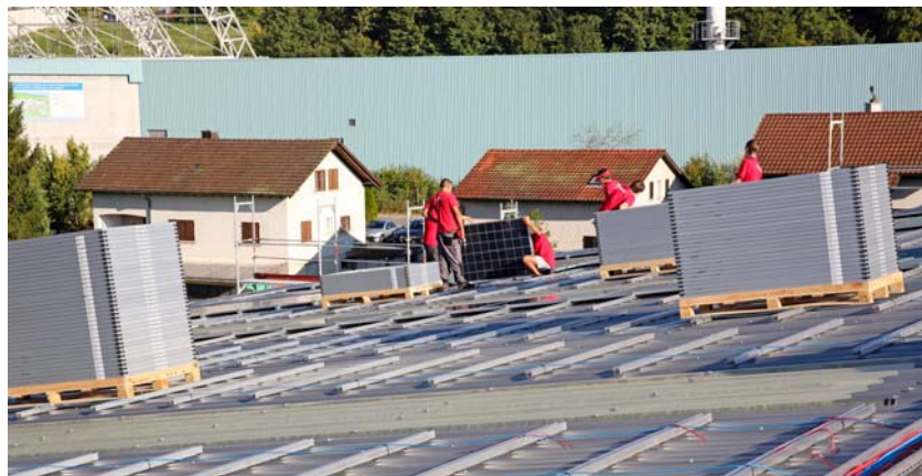
Die Paletten wurden genau nach Plan auf dem Dach abgesetzt.
