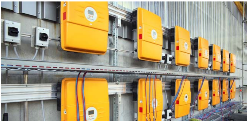
Einige der 32 Wechselrichter während der Montage.
