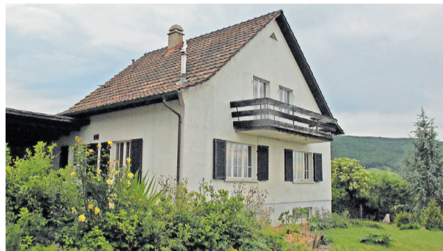
Vorher: Dieses Einfamilienhaus steht in Küttigen
